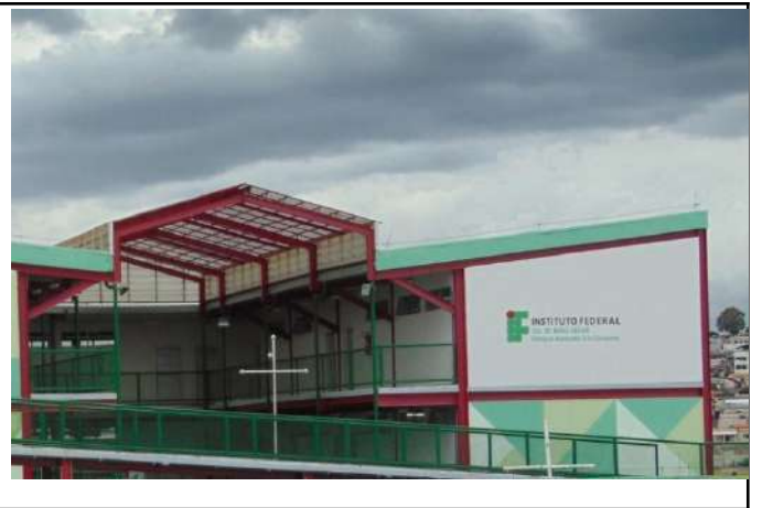
Figure 8: Campus Três Corações natural ventilation and lighting.
