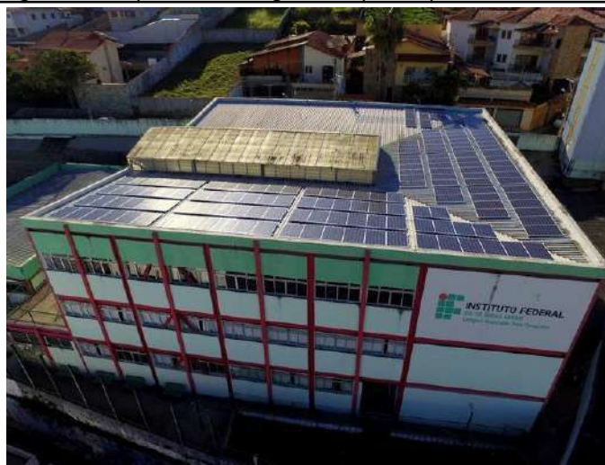
Figure 8: Campus Três Corações solar power plant.
